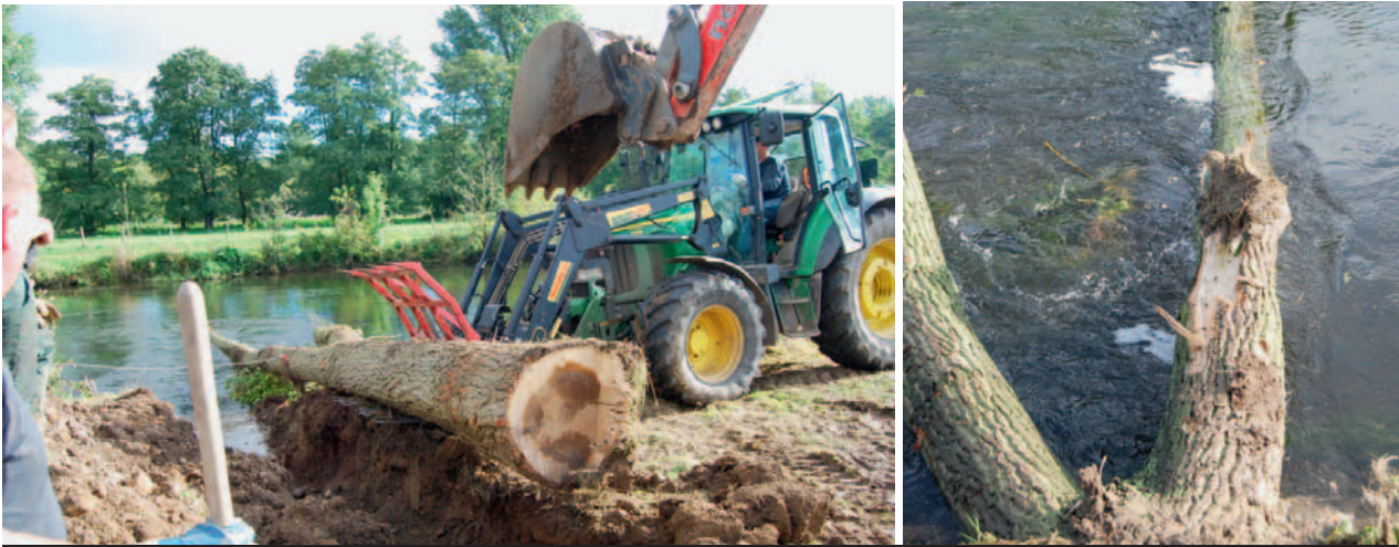
Einbringung eines Totholzstamms in die Rur
