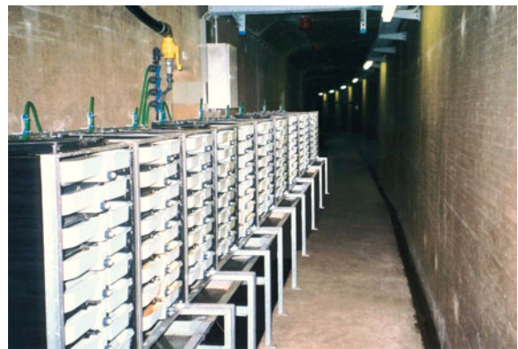
Brutschrankbatterie in der Stauwand der Hasper Talsperre
