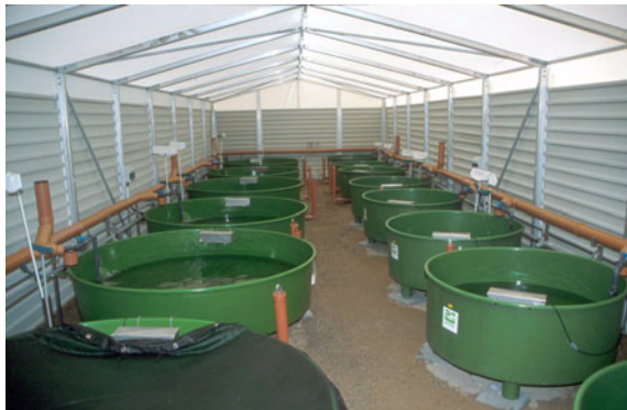
Arbeitshalle mit Rundstrombecken an der Hasper Talsperre
