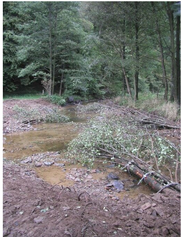
Totholz in Schönenberg nach Einbau 27.09.2002
