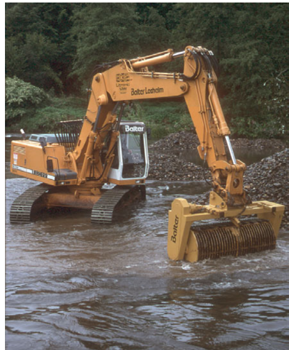
Kiesreinigung mit einem Bagger
