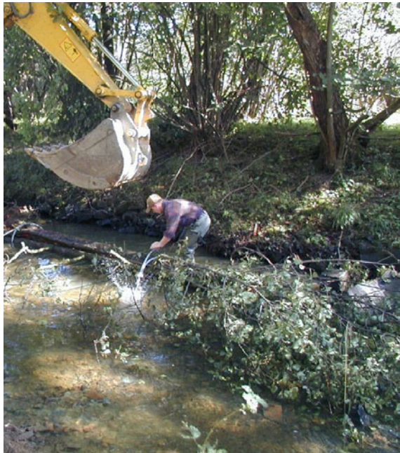
Totholz in Müllerhof, Einbau am 12.09.2002. Die Befestigung der Holzelemente an die Findlinge erfolgte über Rundlitzenseile.
