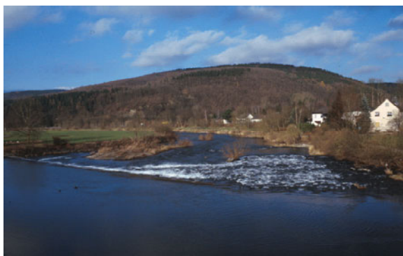
Das umgestaltete Siegwehr in Dattenfeld wurde von Lachsen und Meerforellen passiert.
