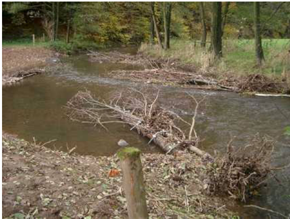
Einbringung von Totholzelementen in die Waldbröl als Ausgleich für den Mangel an natürlichen Fallbäumen. Das Totholz induziert natürliche, eigendynamische Entwicklungsprozesse des Gewässers.
