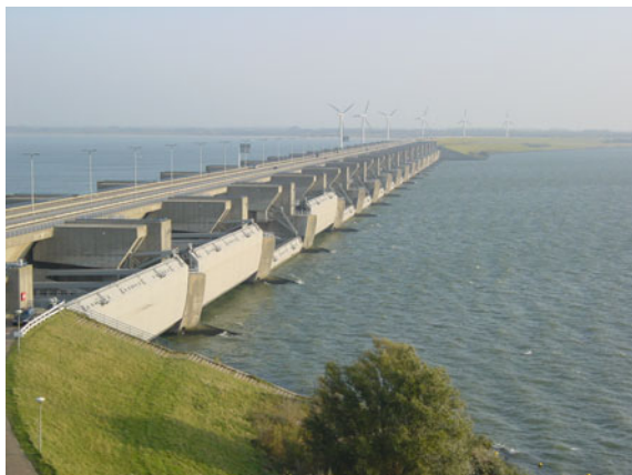
Das Abschlussbauwerk Haringvliet an der Mündung eines Rheinarmes. Sicht von der Flussseite (rechts) zur Seeseite
