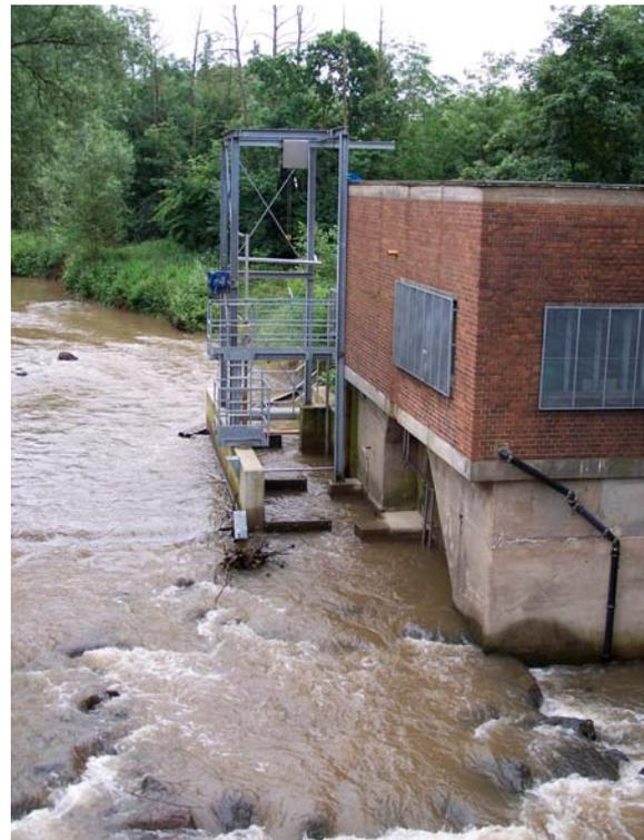
Kontrollstation bei erhöhtem Abfluss und niedergelegten Rechen
