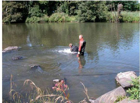
*Einebnen des Gewässergrundes am Aggerwehr Troisdorf mit einem Presslufthammer zur Vorbereitung des Wiedereinbaus der Kontrollstation*
