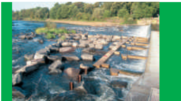
Neue Fischpässe am Wehr Buisdorf an der Sieg
