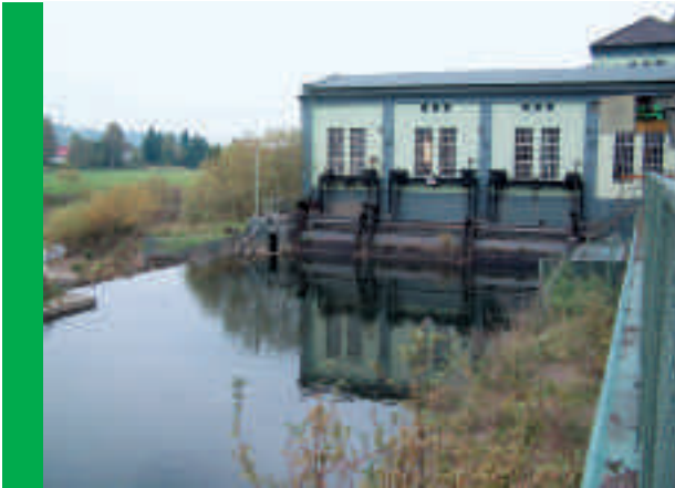
Wehr Unkelmühle, hier soll eine Pilotanlage zum Fischabstieg entstehen
