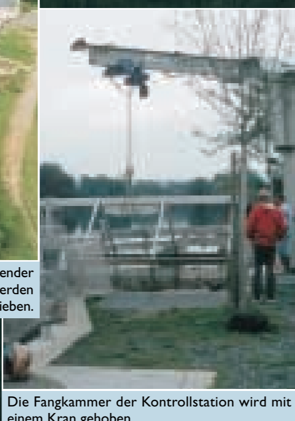
Die Fangkammer der Kontrollstation wird mit einem Kran gehoben.
